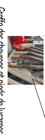
Remplacemnt de poutres de lucarne
